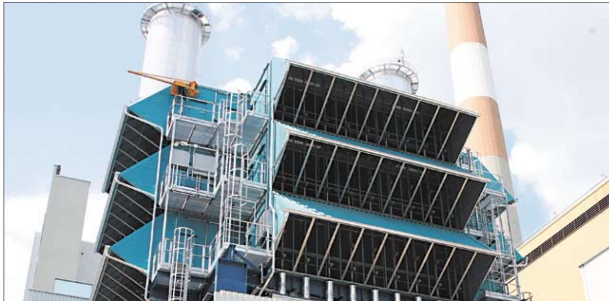
Foto: Wien Energie
